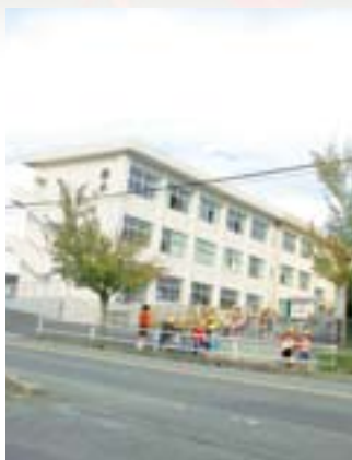
幸田小学校の校舎を増築
