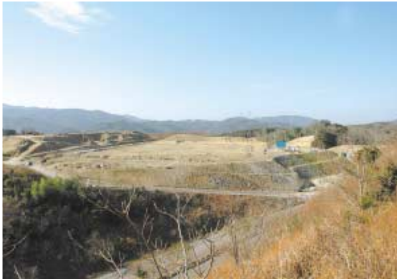
着々と工事が進む(仮)深溝運動場
