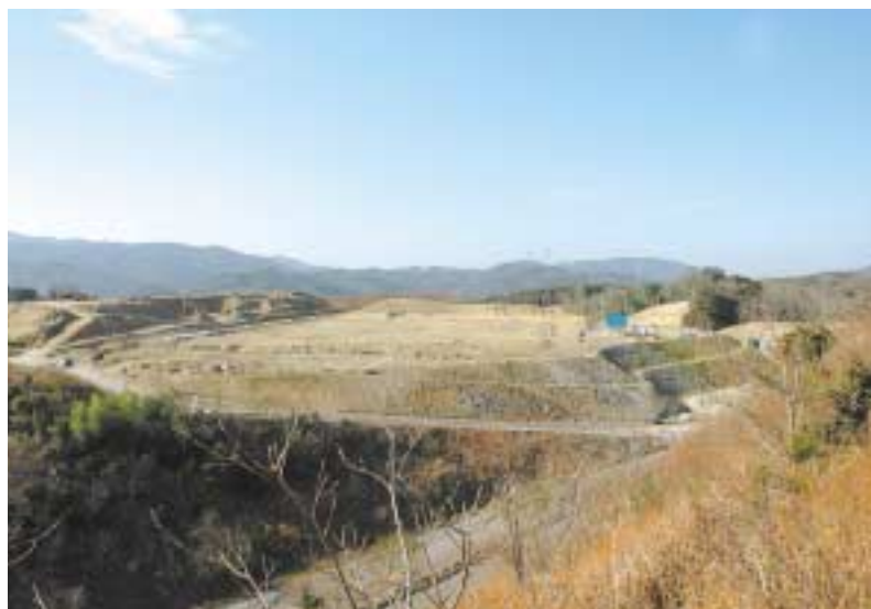
着々と工事が進む(仮)深溝運動場
