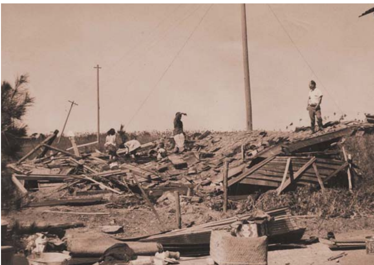
家が崩れて呆然とする家族（菱池地区内）
