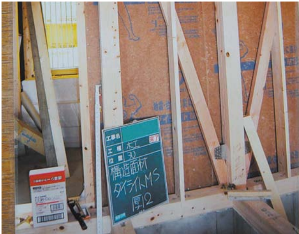
耐震補強で安全な住宅に
