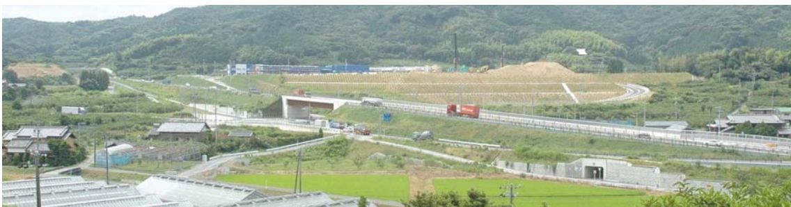
工事の進む須美工業団地
