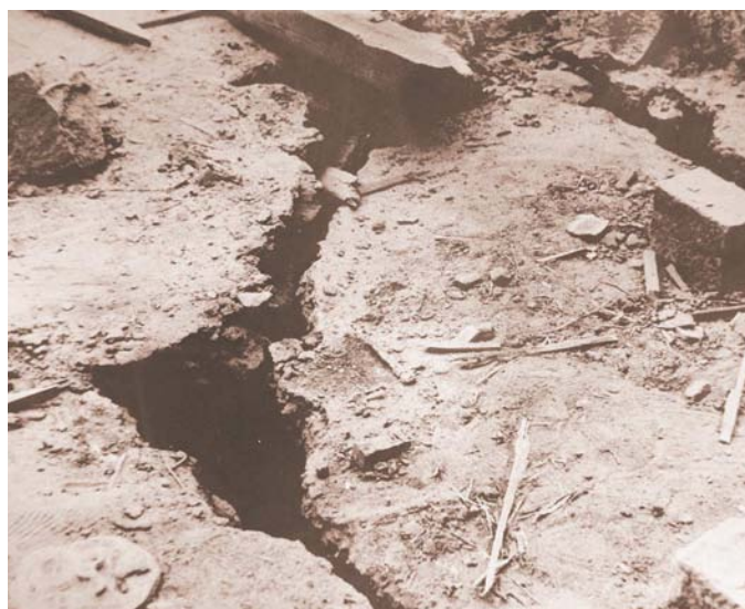
校舎改築時に床下から現れた断層跡（昭和45年）
