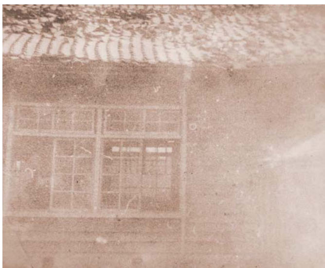
被災した当時の深溝小学校の校舎
