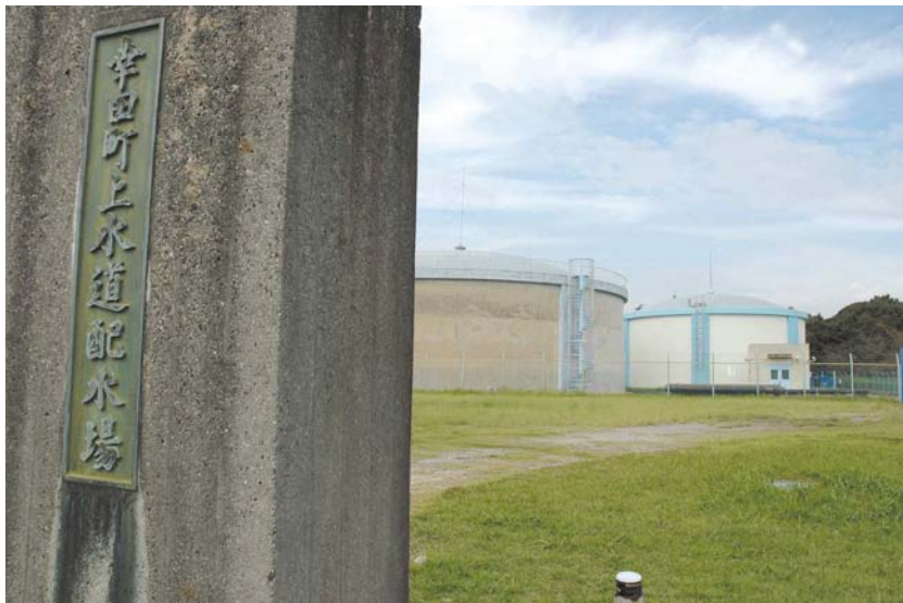
永野公園にある配水場
