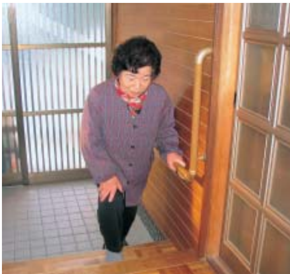
住宅改修された玄関
