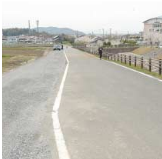
拡幅された光明寺川堤防道路
