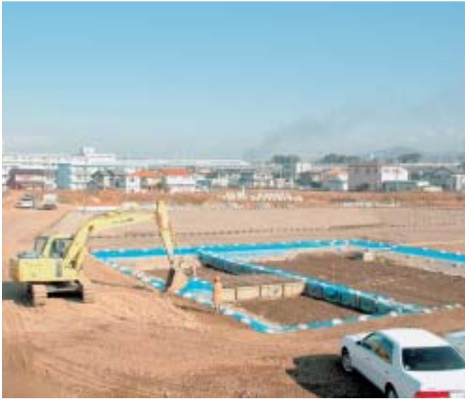
工事の進む一般廃棄物最終処分場
