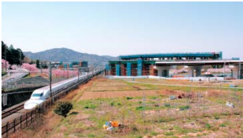
東進する国道23号の橋脚工事
