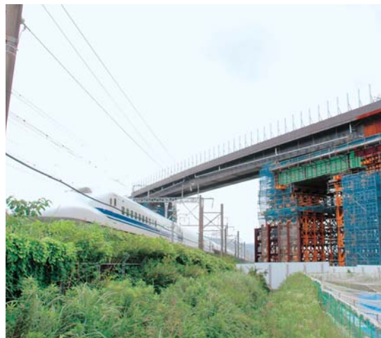
工事が進む幸田芦谷IC付近
