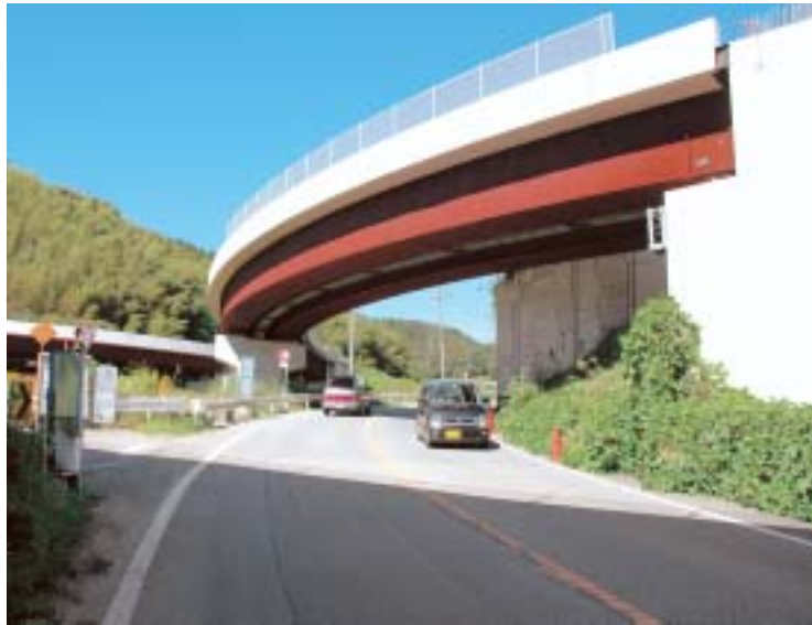
旧幡岡農道と交差する幸田桐山インター付近
