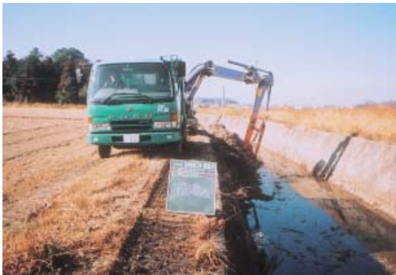
浚渫工事 しゅんせつこうじ をしている相見川
