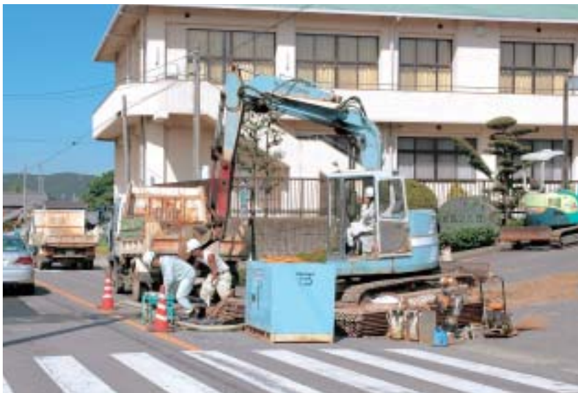
岩堀地内で進む下水道工事
