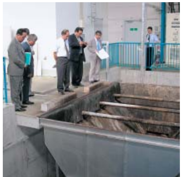
白石市の生ごみ資源化施設
