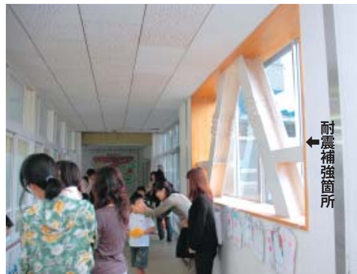
耐震補強の終わった豊坂小学校
