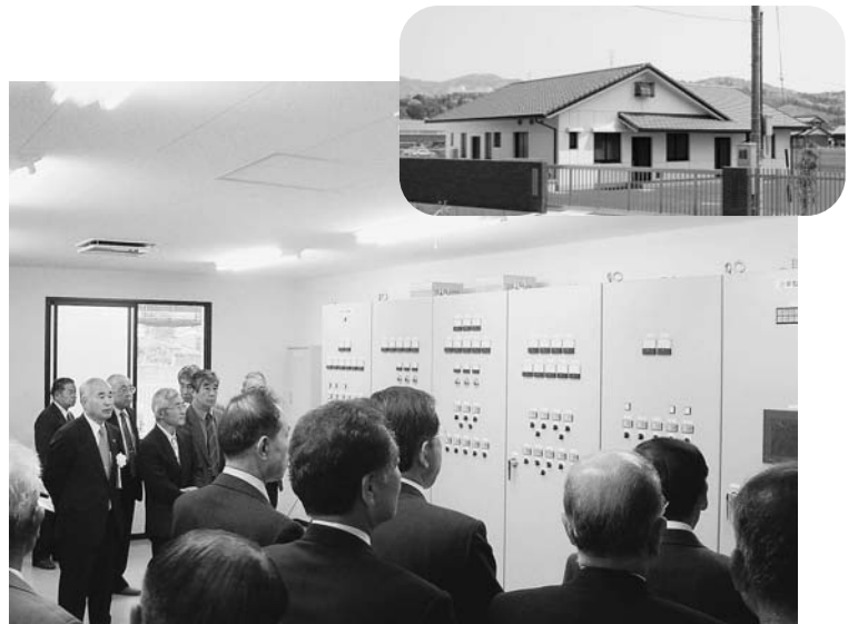
上六栗地区集落排水処理施設の操作盤と施設の全景
