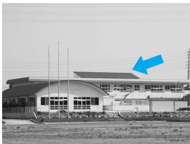
菱池保育園の屋上に設置されている太陽電池パネル
