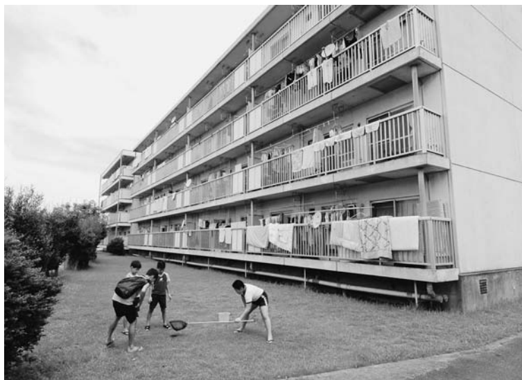
町営横落住宅
