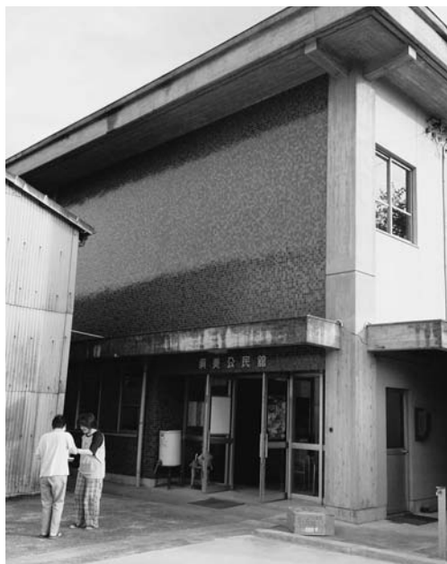
本年度耐震診断予定の須美公民館
