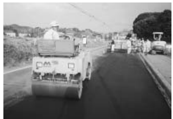
舗装修繕される町道
