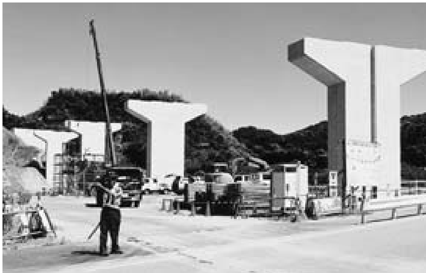
急ピッチで工事が進む名豊バイパス（須美にて）
