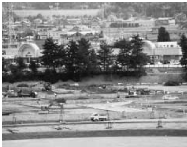
▲ 新しい行政区が誕生する（住宅開発現場）
