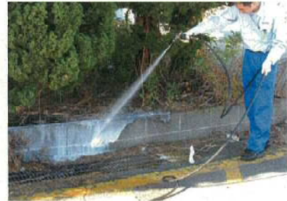
専門業者による液剤の高圧散布
