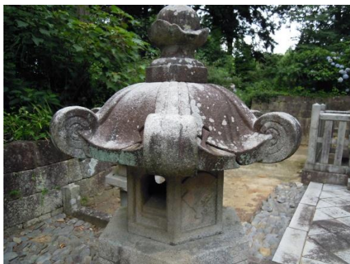
7代忠雄墓付帯燈籠 笠の破損を現代の楔で修理してある。
