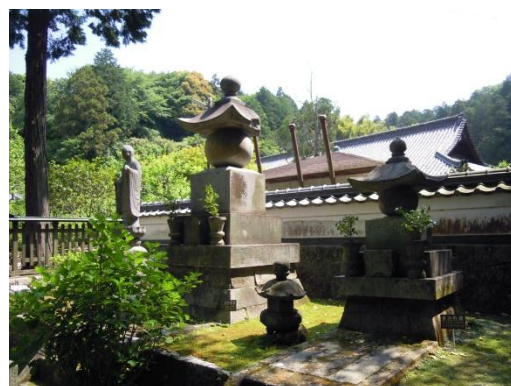
東廟所木戸前 石燈籠2基は竿や基壇が欠失している。築地は戦後にコンクリートで修理された。
