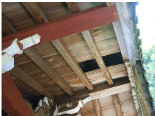
山門 屋根裏に小動物が出入する隙間ができている。
