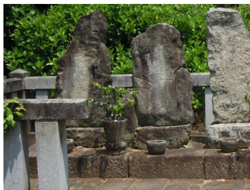
3 代伊忠供養塔（中）は正面背面ともに亀裂が入る。4 代家忠供養塔（左）は、碑文表面の風化が著しい。背面に亀裂が入っている。
