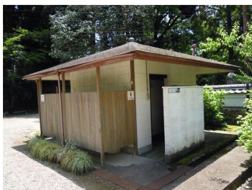
境内地のトイレ 汲取式でバリアフリーに対応していない。
