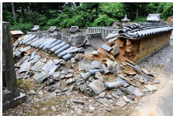
写真 3-34 三河地震で破損した築地
