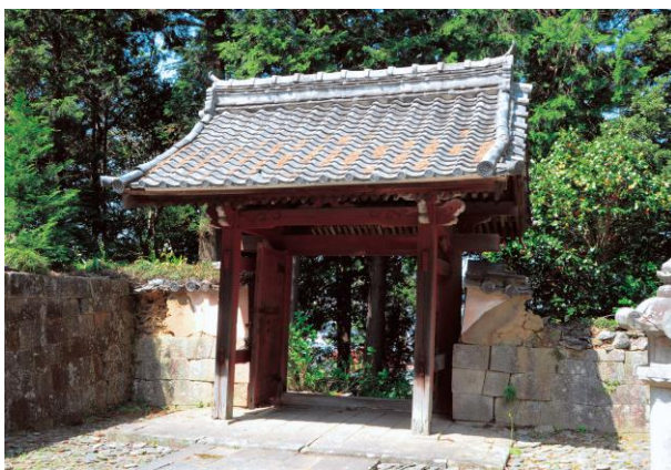
写真 3-12 東廟所 (門内より)
