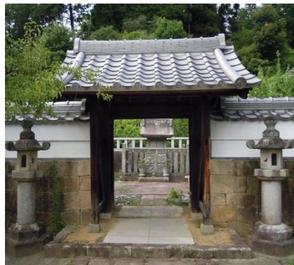
写真 3-8 11 代忠恕石殿門
