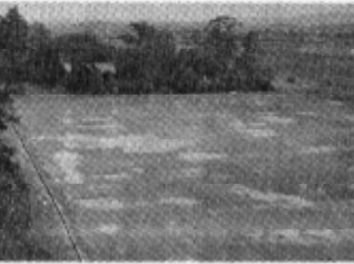
→六栗住宅地造成工事完成
