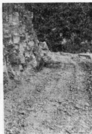
(林道鷺ヶ峯線開発現場)
