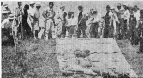
① 水防訓練 (月の輪工法) ② 水防訓練 (遊振り工法)
