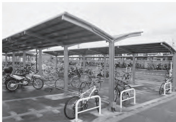
↑幸田駅前駐輪場改修工事
