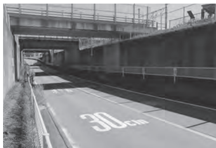
アンダーパス施設安全対策
