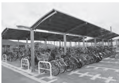
幸田駅前駐輪場整備
