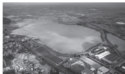
↑平成20年8月末豪雨で浸水した菱池遊水地事業地区
