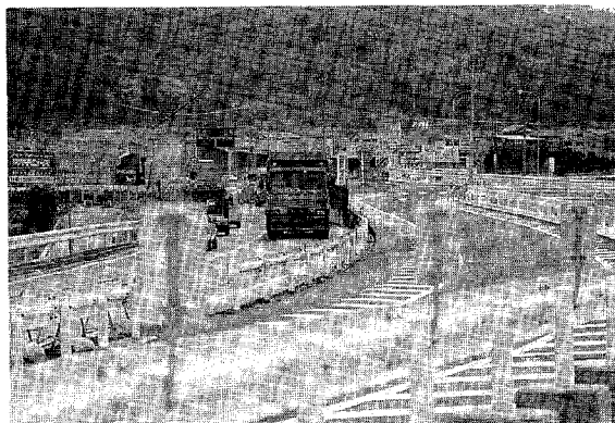
▲工事進行中の都市計画道路衣浦蒲郡線
