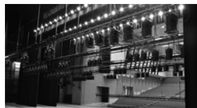
▲町民会館舞台照明・音響設備改修
