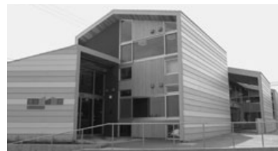
▲多世代交流施設（豊坂ほっと館）の建設
