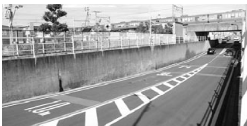
▲路面標示がされた錦田のアンダーパス
