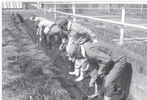
▲水路の泥上げの様子
