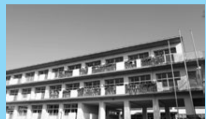
▲幸田小学校増築工事
