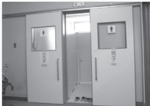
▲2階トイレも改修され男女別々になりました
