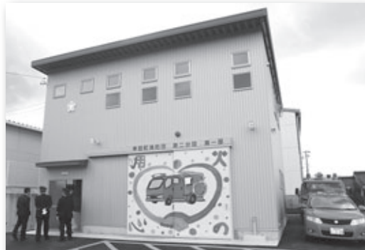
▲完成した消防団第2分団第1部の新詰所
