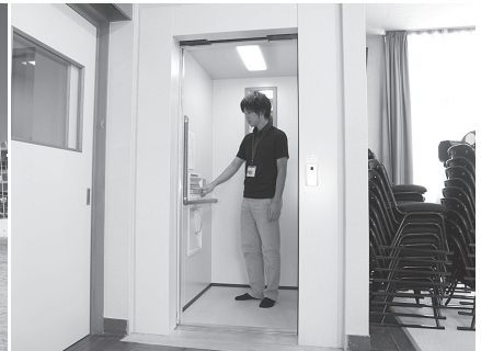
老人福祉センターエレベーター改修工事
