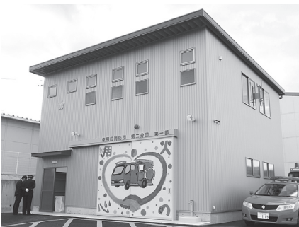
消防団第2分団詰所建設工事
