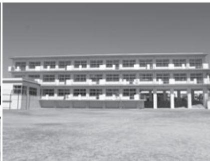
幸田小学校校舎増築工事
