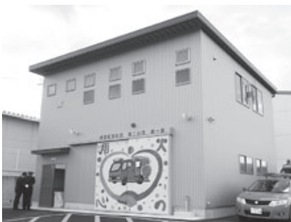
消防団第2分団詰所建設工事
