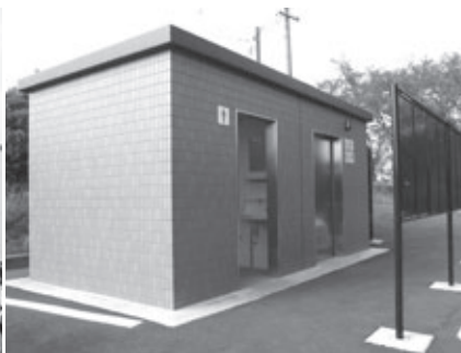
永野公園整備事業（トイレ整備）
