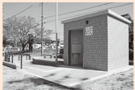
里前・沢渡公園(深溝)に多目的トイレ設置 1,722万円
