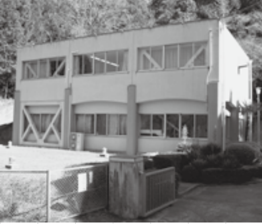
▲永野ポンプ場
