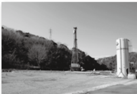
▲工事が始まる現地の様子
