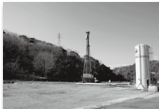
▲工事が始まる現地の様子
