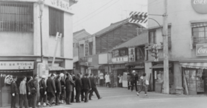
▲昭和43年、町内第1号となる信号機を幸田駅前交差点に設置
