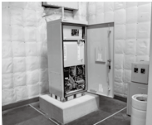
防災無線専用の自家発電装置
