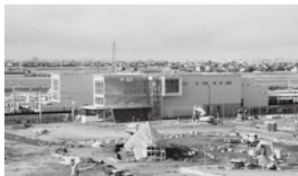
▲建設中の相見駅(平成23年12月26日撮影)
