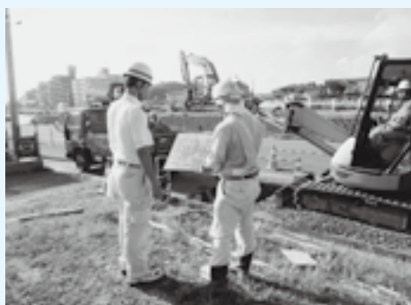
▲工事現場の進捗確認
