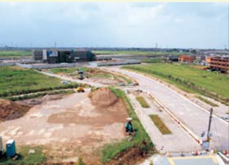
▲着々と工事が進む相見駅東側（8月17日撮影）
