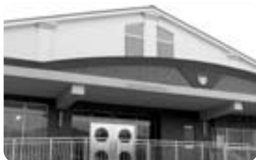
▲改築した中央小学校体育館
