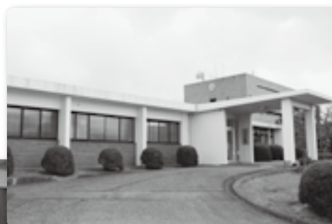
幸田中央公園管理棟
