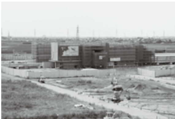
▲工事が着々と進む相見駅
